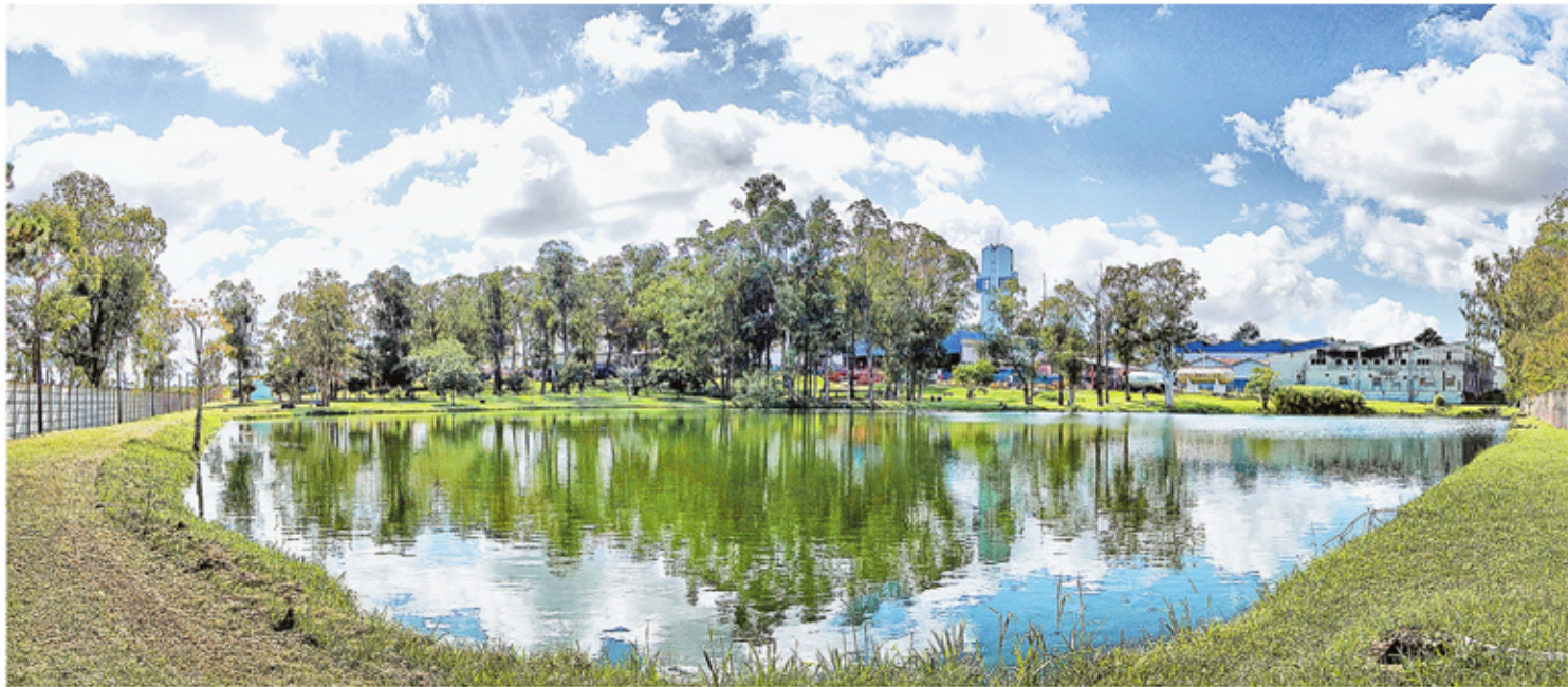
O lago instalado na unidade industrial da ThyssenKrupp em Guaíba, Rio Grande do Sul, recebe água de estação de tratamento de efluentes
